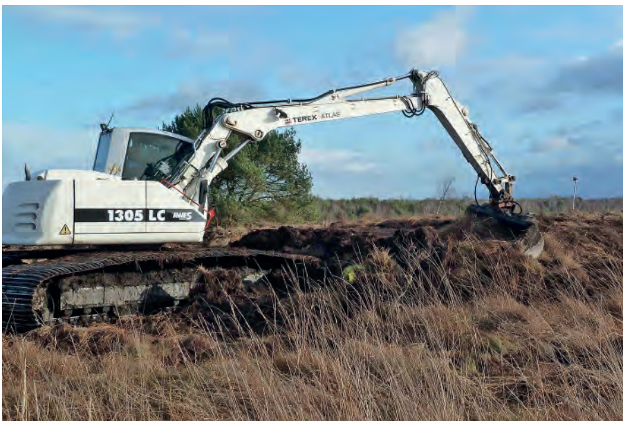
Die Anlage von Verwallungen zur Optimierung des Wasserhaushaltes in Hochmooren kann in LIFE-Natur-Projektgebieten auch mit EU-Mitteln gefördert werden. (Foto: Jens Fahning)
