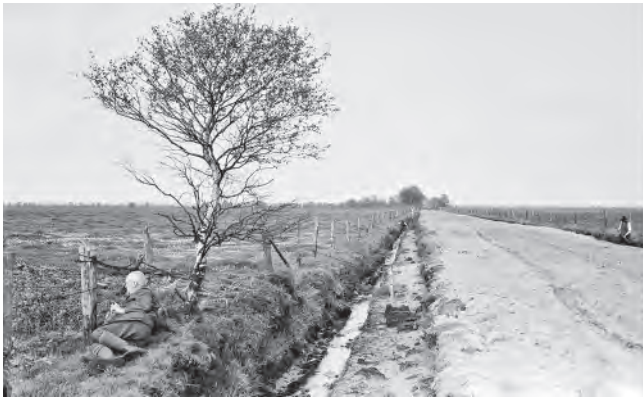
Weidegrünland auf Weißtorf (Deutsche Hochmoorkultur) im Schweger Moor 1936: links mit sandbedecktem Damm und Entwässerungsgräben, rechts mit angrenzendem Torfabbau (Fotos: Niedersächsisches Landesmuseum Hannover)
